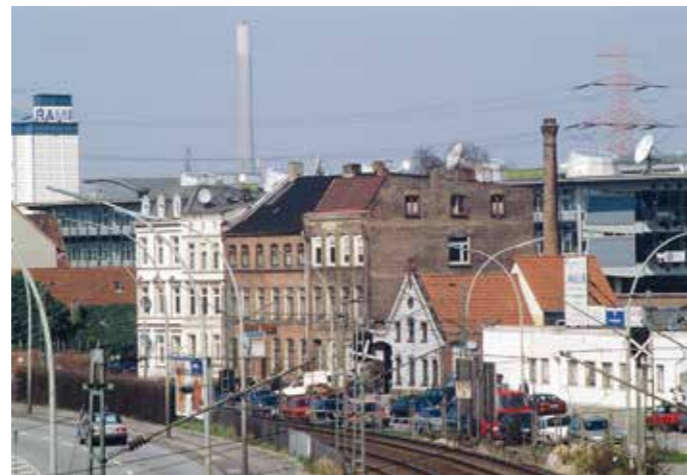
Die kleine Likörfabrik am Karnapp 15/16 in Hamburg-Harburg mit zwei ziegelichtigen Gebäuden an der Straße (gegenüber die Unterelbebahn) fügt sich gut in die Bebauung ein – nur der Schornstein auf dem Hof weist auf die Funktion hin. Foto: Sven Bardua, 1999
