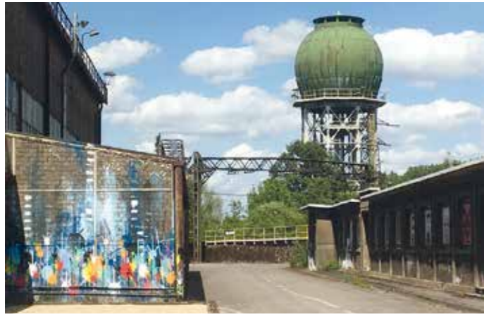
An Wochenenden kann jedermann das schon teilweise abgebrochene Stahlwerk Schiffflange („Metzeschmelz“) erkunden. Foto: Alexander Kierdorf, 2022
