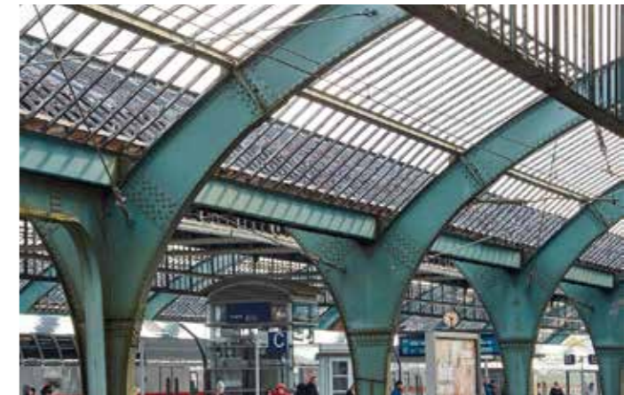
Die schlicht gestaltete Gleishalle des Bahnhofs Oldenburg ist auch Ausdruck des leistungsfähigen Stahlbaus vor dem Ersten Weltkrieg. Foto: Roland Rossner / Deutsche Stiftung Denkmalschutz, 2016
