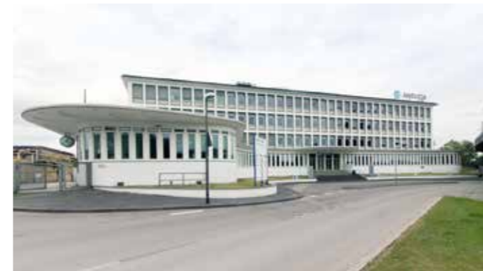
Am Werkseingang dient das Bürohaus der Thyssen Draht AG seit 2017 dem Callcenterbetreiber Amevida als Sitz. Foto: Dr. W. Strickling / Wikimedia Commons, 2020
