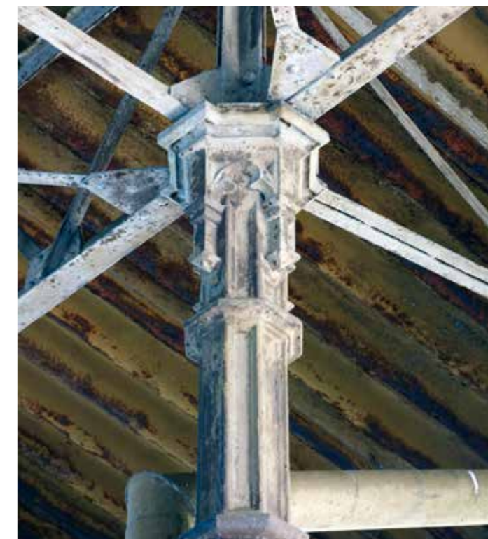
Auf der Gleisseite des Unteren Bahnhofs blieb ein Bahnsteigdach mit Stützen von 1866 erhalten. Foto: Alexander Calvelli, 2020
