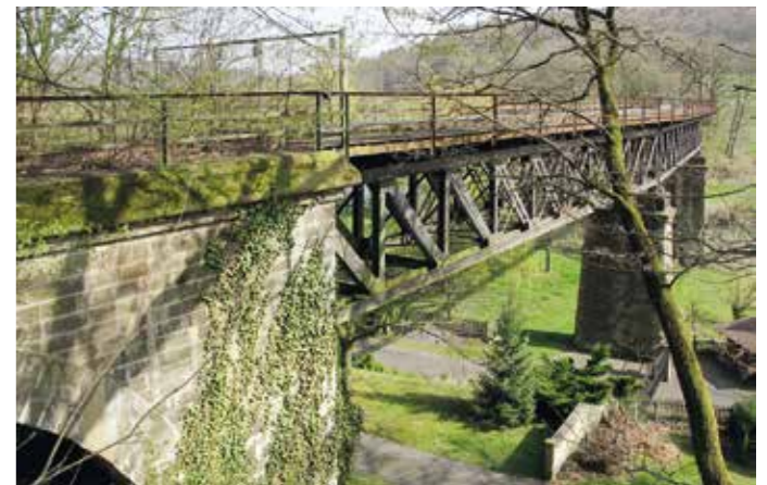
Zwischen großen Naturstein-Widerlagern quert das stählerne Eisenbahnviadukt der Ohmtalbahn bei Homberg den Fluss. Foto: Klaus Foehl / Wikimedia Commons, 2014
