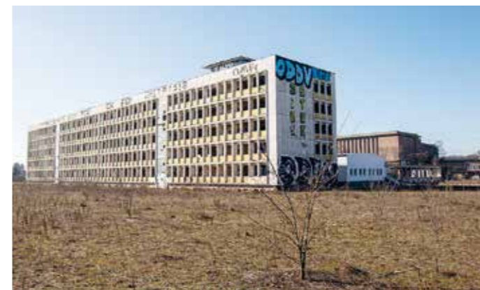
Von der Rummelsburger Landstraße aus ist der viergeschossige Block E-R gut zu sehen. Dahinter befinden sich der niedrigere Block E-T sowie der große Bestand des 1956 eingeweihten Funkhauses Berlin. Foto: Trockland Management GmbH, 2019
