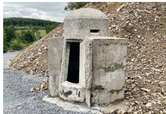
Die auch im Erdboden durch eine kräftige, nicht sichtbare Betonplatte gesicherte Splitterschutzzelle steht jetzt im Steinbruch des LVR-Freilichtmuseums Lindlar. Foto: Michael Kamp, 2022
