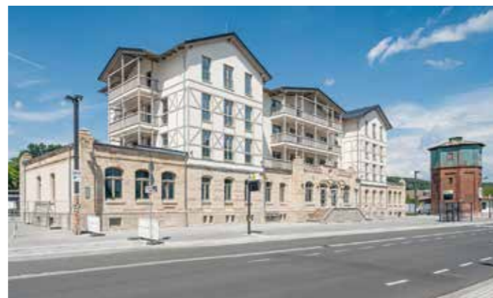
Neben dem durchsanierten Bahnhof stand 2020 noch der damals original erhaltene Wasserturm. Foto: A. Savin / Wikimedia Commons
