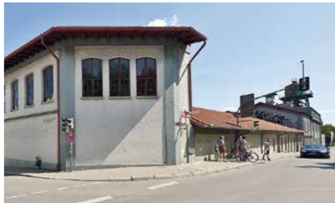
Die Bauten der Papierfabrik an dieser Straßenecke (links Kalenderhalle, rechts Papierhallen mit Wasserturm) sollen erhalten bleiben. Foto: Isaria München Projektentwicklungs GmbH, 2017
