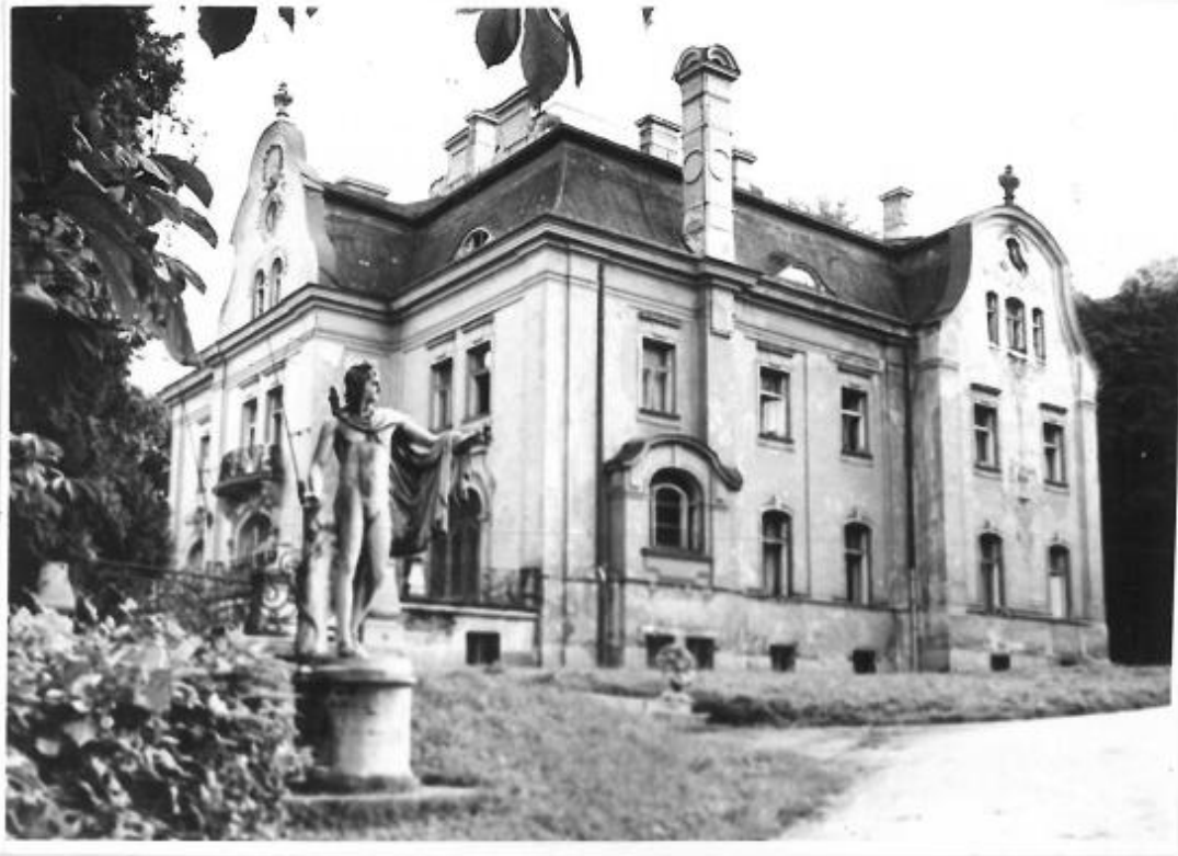
1972 erfolgte der Abbruch der historischen Hatschek-Villa am Bauernberg.
